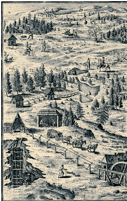
Homann'sche Erben: „Prospecte des Hartzwalds“, um 1750 (Ausschnitte) Darstellung bergbaulicher Aktivitäten, darunter die Absteckung eines Grubenfeldes, Kraftübertragung durch ein Feldgestänge, ein Pochwerk, sowie Göpel über Gruben und Arbeit der Bergleute in einer Grube.
